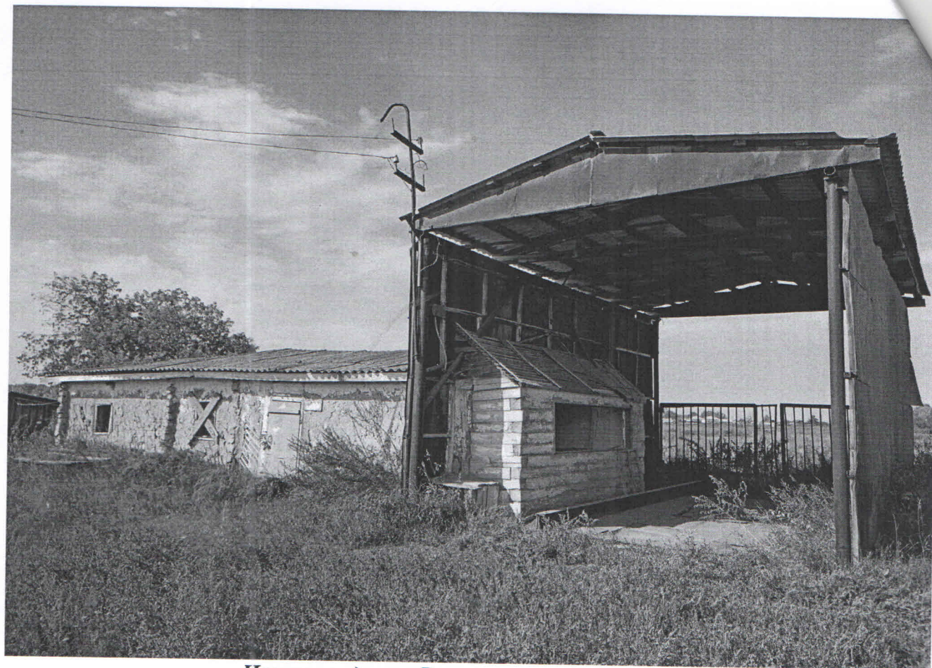
Нежилое здание, Весовая, площадь 65,4 кв.м.
