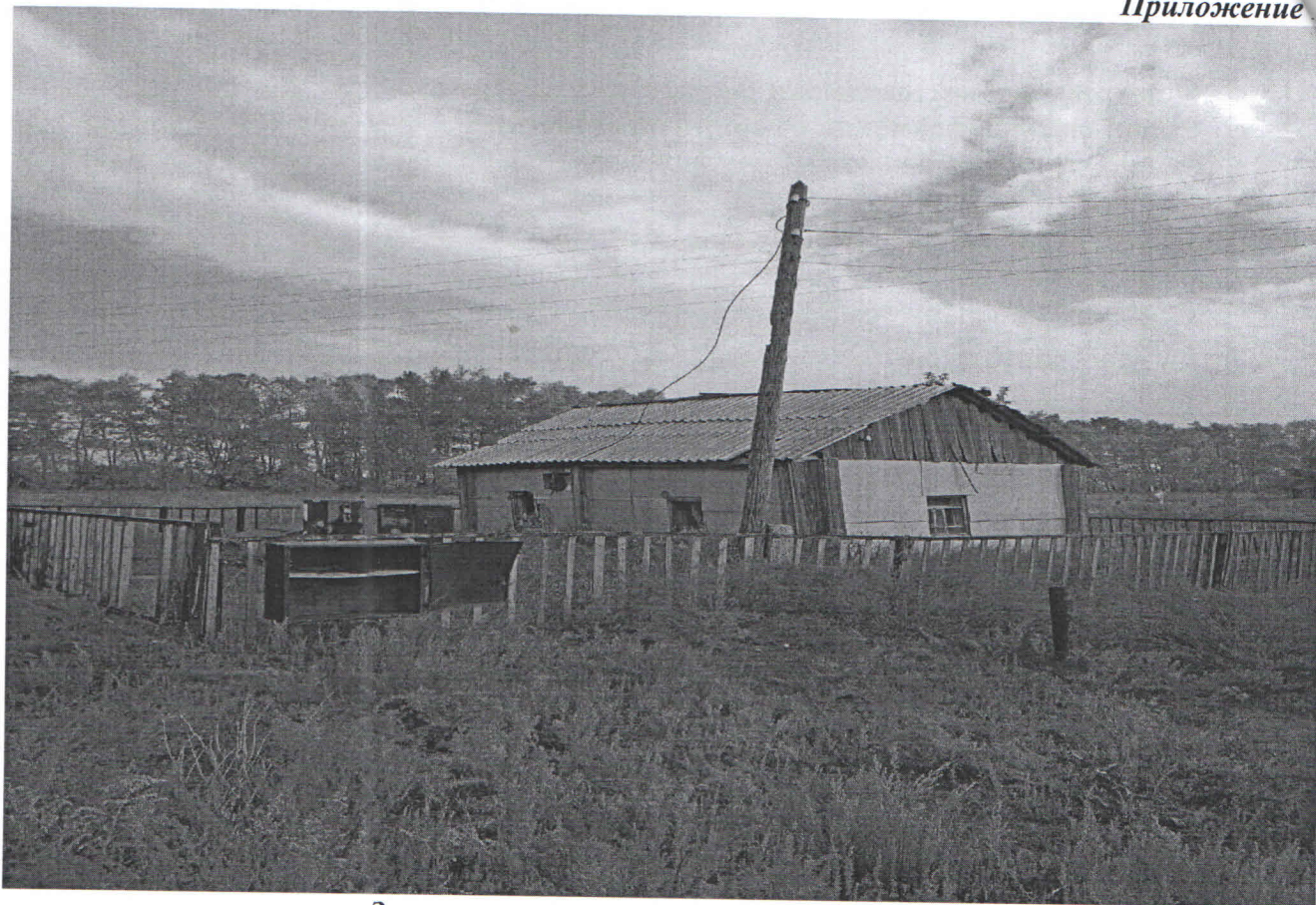
Заправочная станция, площадь 16,4 кв.м.
