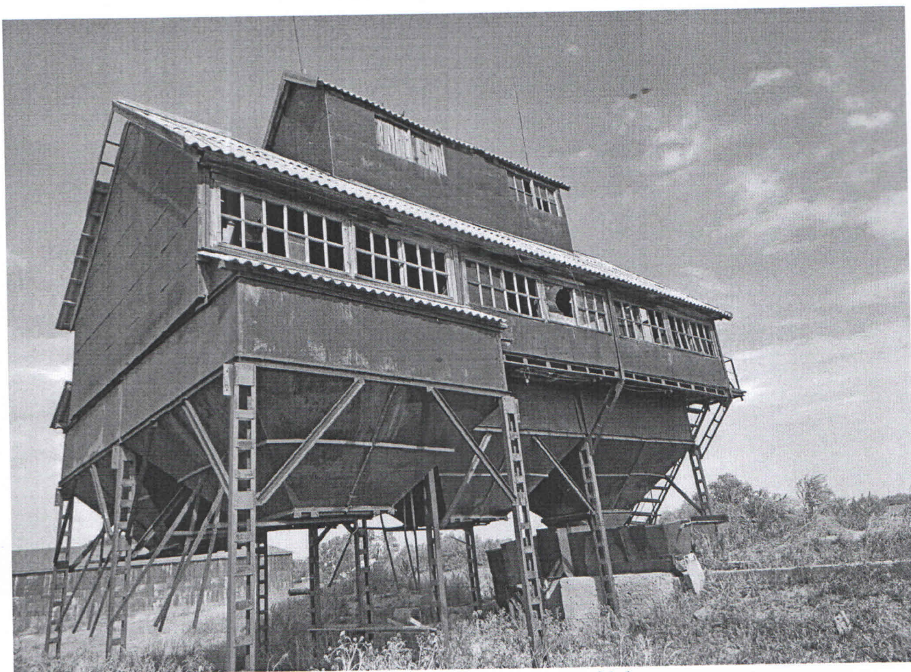
Нежилое здание, ЗАВ 50, площадь 98,8 кв.м.
