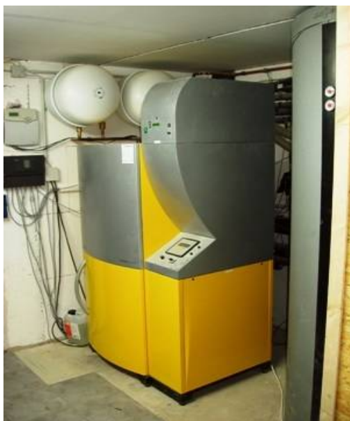
Твердотопливный котел, работающий на пеллетах BIOMASTER CS
